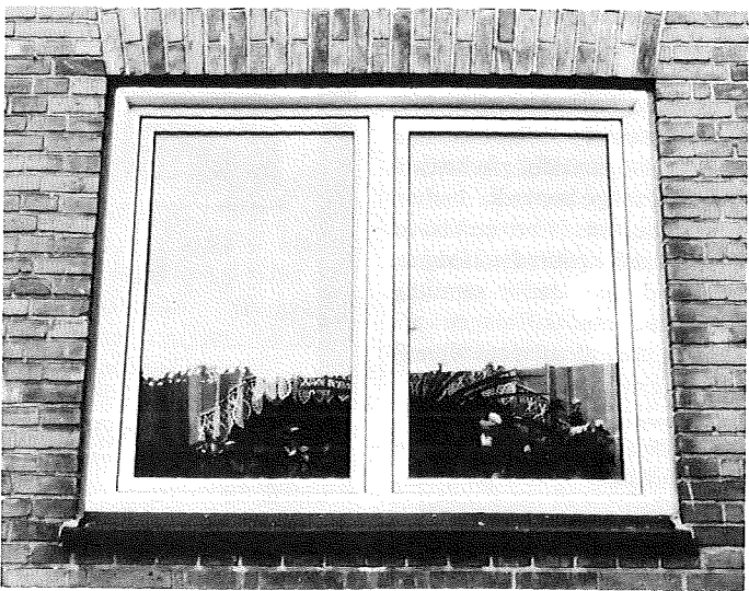
Fig. 6. Vindue fra blok 6. Profileringen giver et mindre massivt udseende end for vinduet vist på figur 5.
